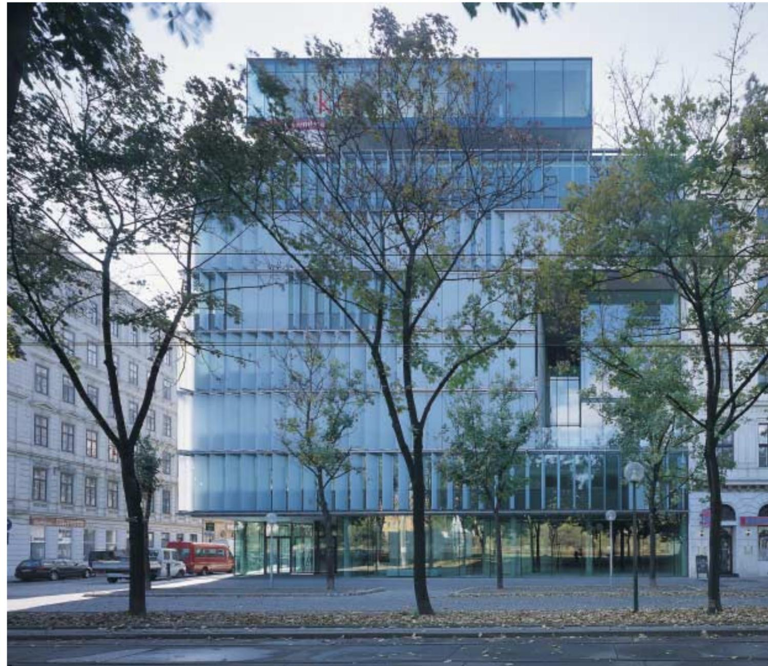
Vertikal drehbare Lamellen: individuell steuerbare Lichtsituationen
